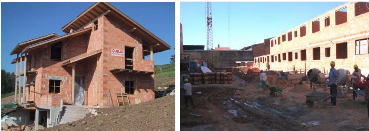
Figura 2 – Exemplos de estruturas resistentes em alvenaria.
